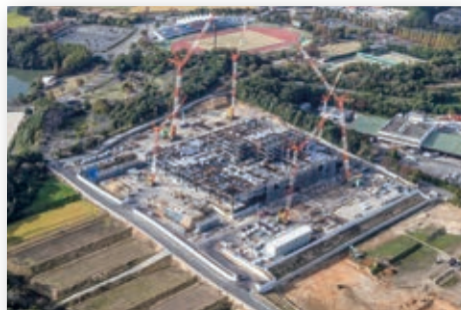
写真1 工事現場全景 (令和5年11月21日撮影)
