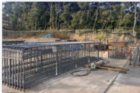
写真2 鉄筋コンクリート梁の地組み
